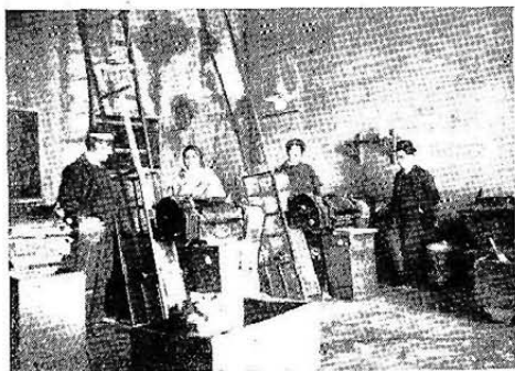
Cortado de la pólvora para fusil, y cortado con guillotina de las pólvoras tubulares para cañón
